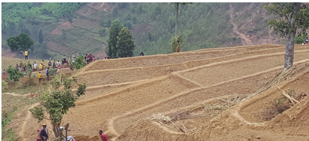
Terrassement de 5.4 Ha à Gashari
